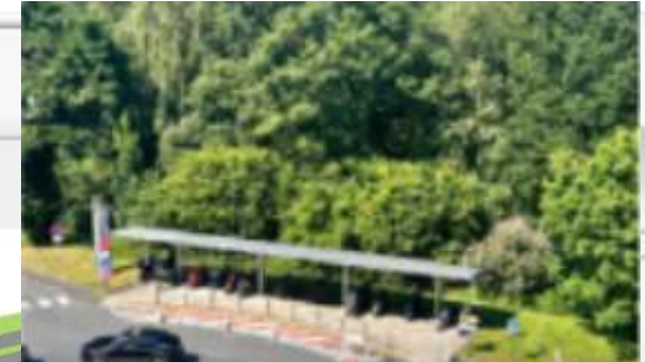
Parking vélo extérieur
