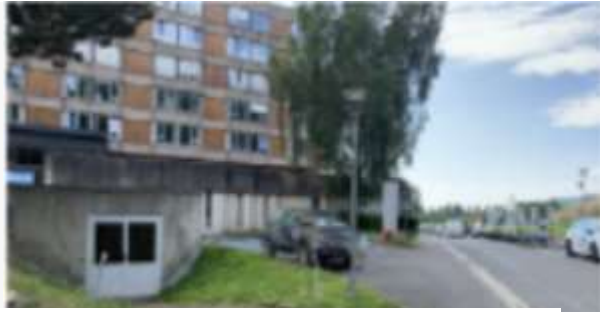
Parking Vélo SUD2* – ancien local hyperbar, derrière le bâtiment sud (25 places)
